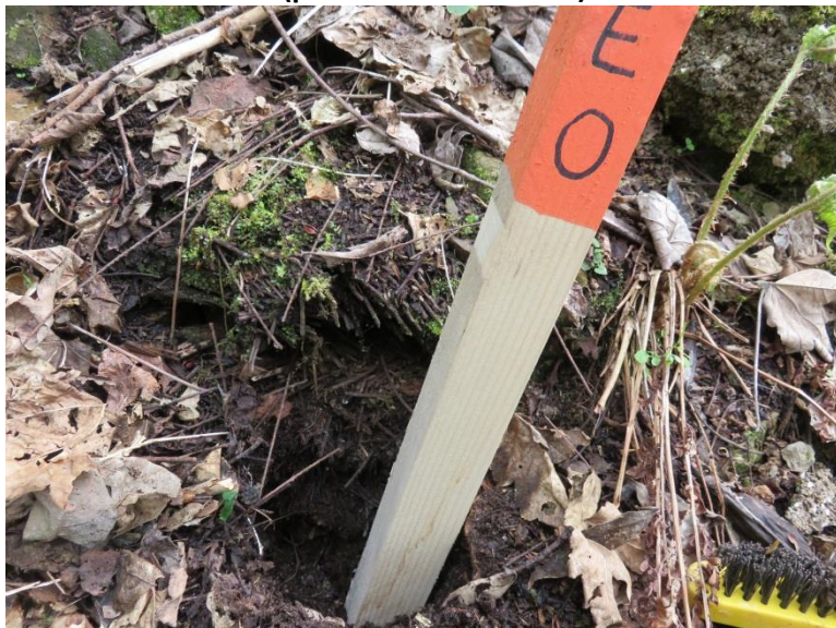
Photos 16 et 17 : E.0 (présence de ferrailles)
